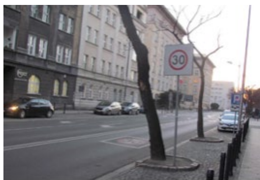
Rys. 3.5. Oznakowanie początku strefy „tempo 30”, ul. Jagiellońska Katowice, źródło: opracowanie własne
