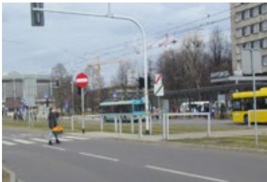
Rys. 3.11 Przejście dla pieszych w Ciągu Alei Korfantego Katowice, źródło: opracowanie własne
